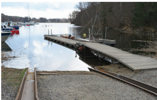
Gamla slamkryparrampen, nu förstärkt och fixad så att den framöver klarar många sjösättningar och torrsättningar med slamkrypare och trailar.
