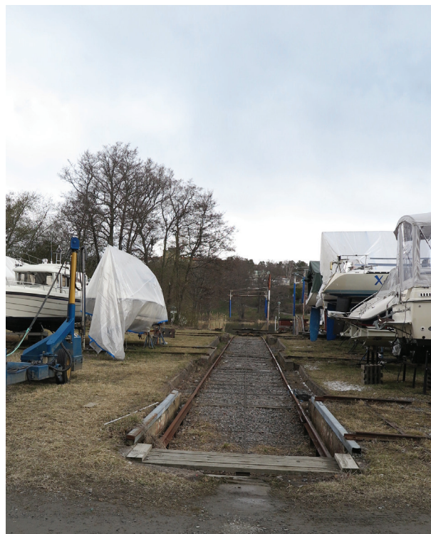
Gamla slipspåret och rampen som kommer att byggas om under sommaren och ge utrymme för effektivare sjö- och torrsättning från och med hösten.
