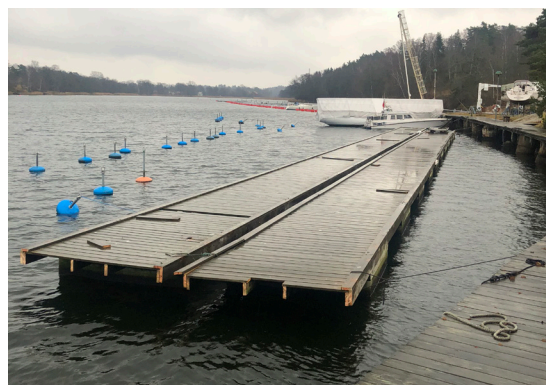
Längs strandbryggan väster om mastkranen, ligger nu den extra pontonbryggan – delad i 2, i väntan på att monteras lagom till sjösättningen!
